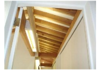
高い天井部と構造仕上げ
