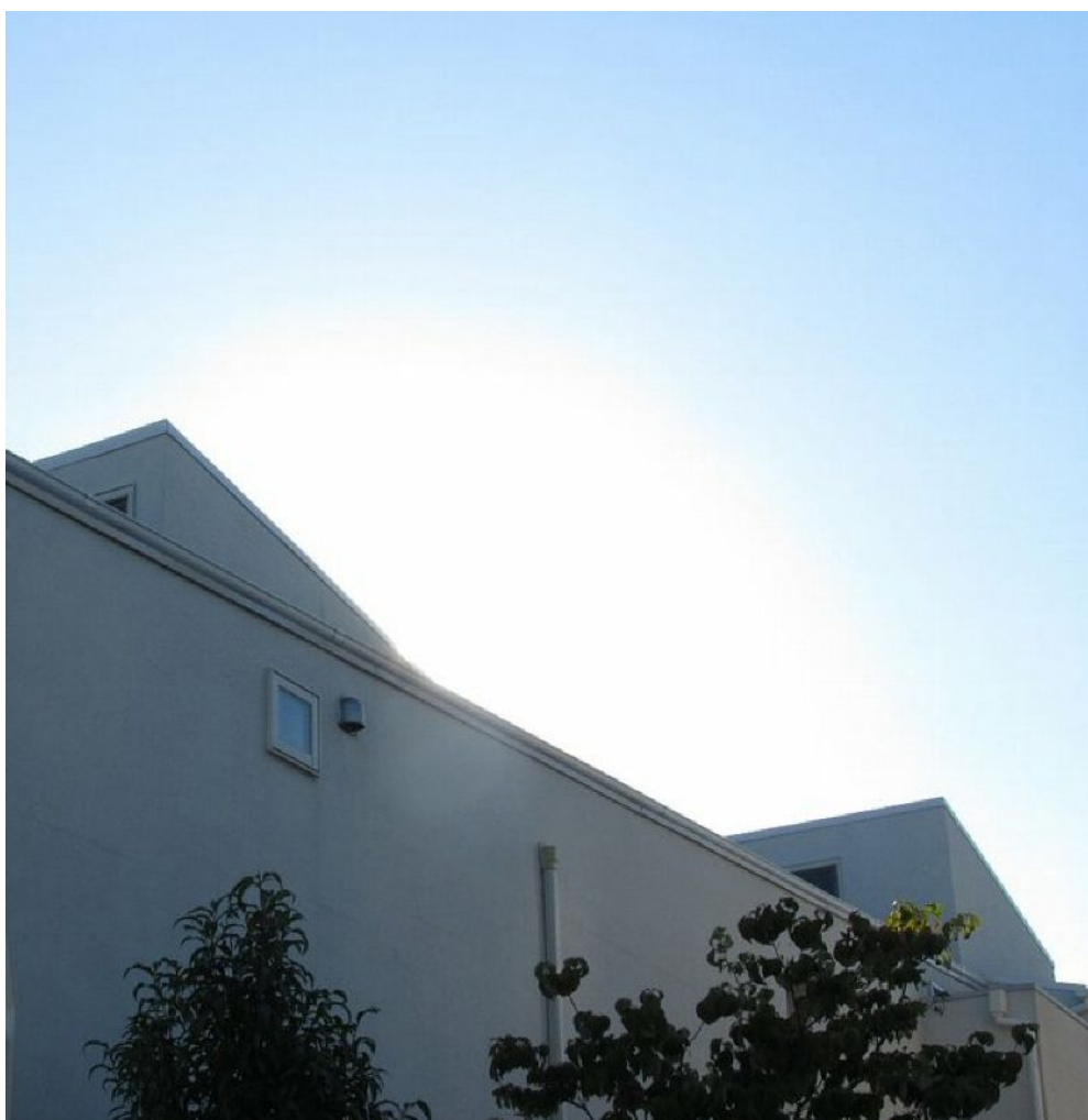
北東側からルーフスカイライトのシルエットを見る
