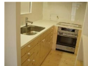
床木材を転用したオリジナル製作キッチン
